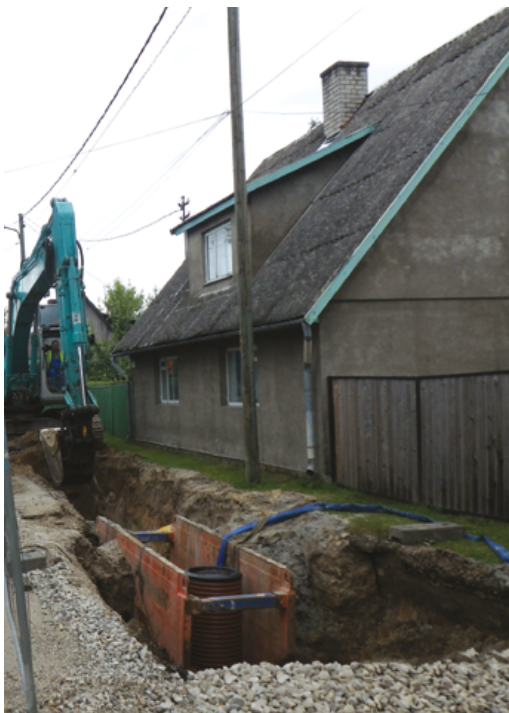
Kaevandis kasutatakse tugielementi, mille vahel töötamisel on töötaja kaitstud nõlva varisemisest
