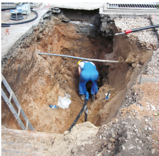
Kaevandi varisemisohhtlikud nõlvad on jäetud enne tööde alustamist toestamata
